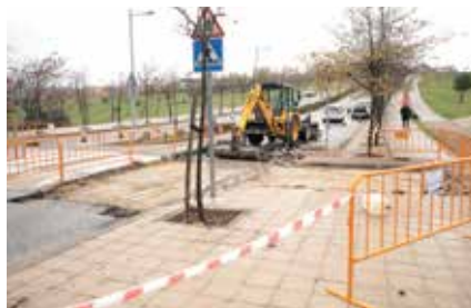
▲ Vista de una de las actuaciones en los badenes.
