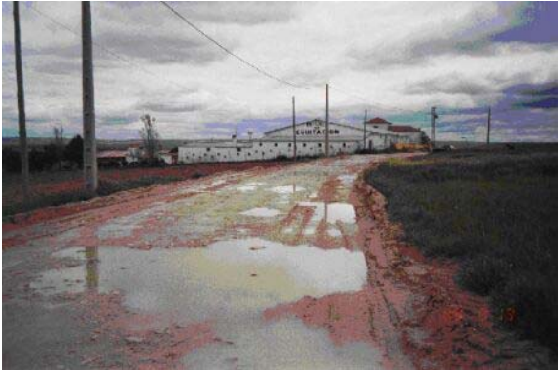
Figura 10. Colada del Camino de Barajas a Torrelaguna
