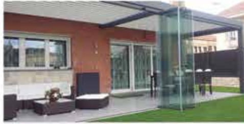
Cerramientos de Terrazas Patios y Porches
