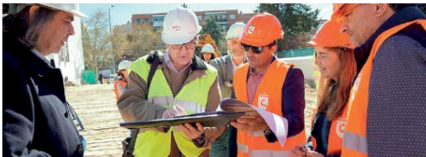
▲ En el pabellón municipal Valcanera se han iniciado las obras de una profunda reforma integral.
