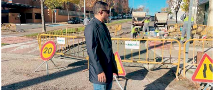
▲ Obras de adaptación y eliminación de badenes en Dehesa Vieja.
