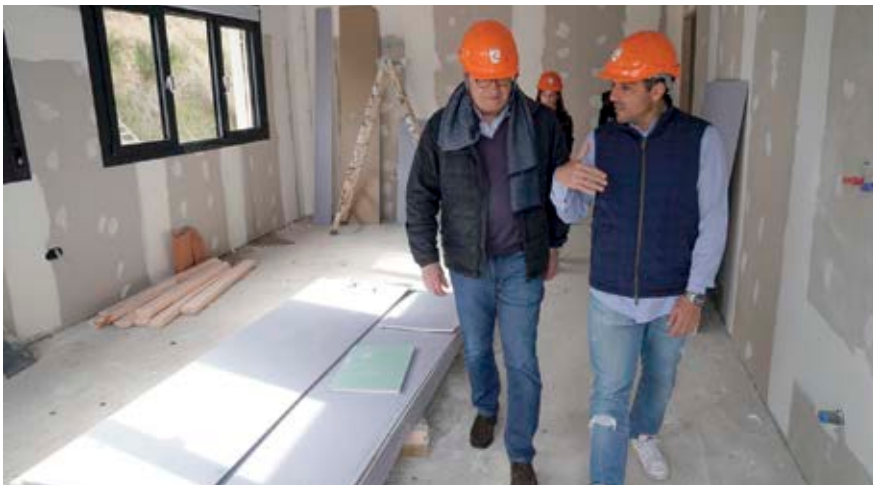
▲ Las obras del futuro Centro sociocultural del Fuente del Fresno, a punto de finalizar.
